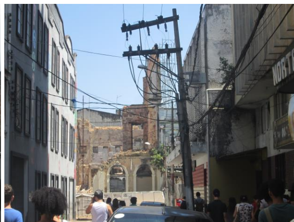
FIGURA 15 - Fachada do prédio destruído, visto da rua Padre Prudêncio
