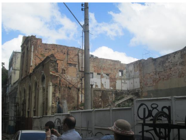
FIGURA 14 - Travessa Leão XXIII esquina com Avenida Conselheiro João Alfredo, próximo à loja Paris n'América. O prédio foi alvo de incêndio.
